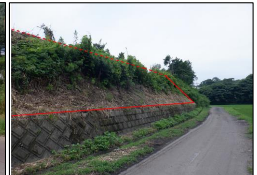
地形狭長かつ法面の土地
